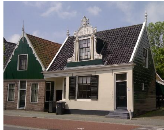
Figure 2: Early 18 th century house in Krommenie (Zuiderhoofdstraat 115) with a façade decoration of sail cloth merchants. (© Jan van Oostveen)
